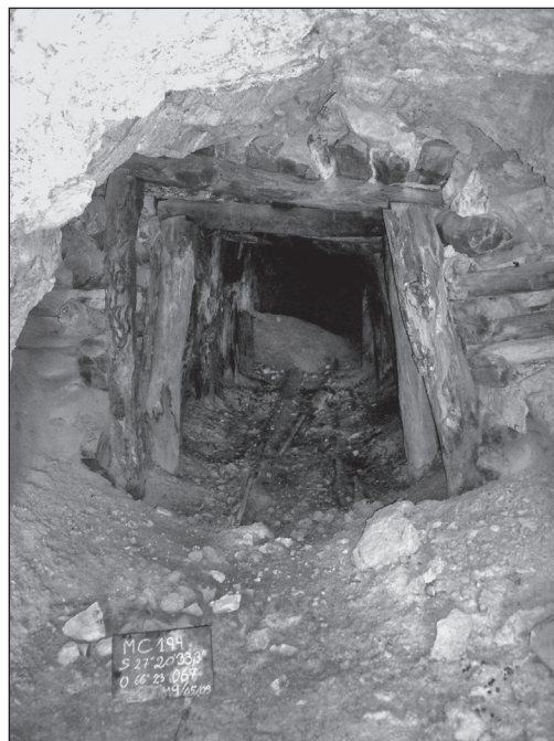
Figura 3. Tendido de rieles en el interior de Mina San Salvador.
